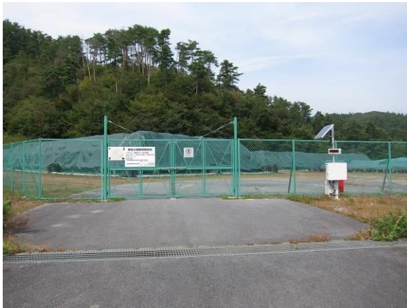
管理設備（楢葉町）
