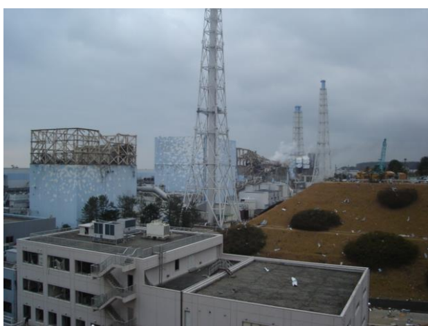
図1-1 事故後の福島第一原子力発電所 (左から1、2、3、4号機) 平成23年3月15日撮影
