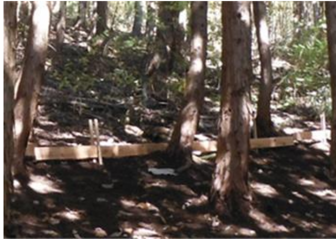
図 4-22 林の除染等の措置の例（土砂流出防止対策）
