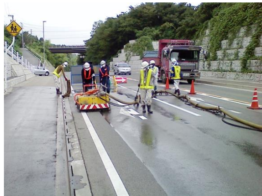
超高圧水洗浄
