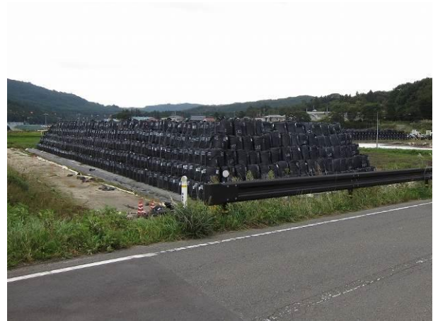
施工中の仮置場（飯舘村）
