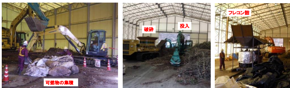
図 4-34 破砕施設内：集積（左）、投入・破砕（中央）、フレコン詰め（右）
