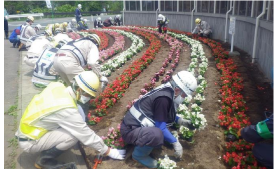
前田建設工業(株)提供 国道6号の花壇の植栽 双葉町
