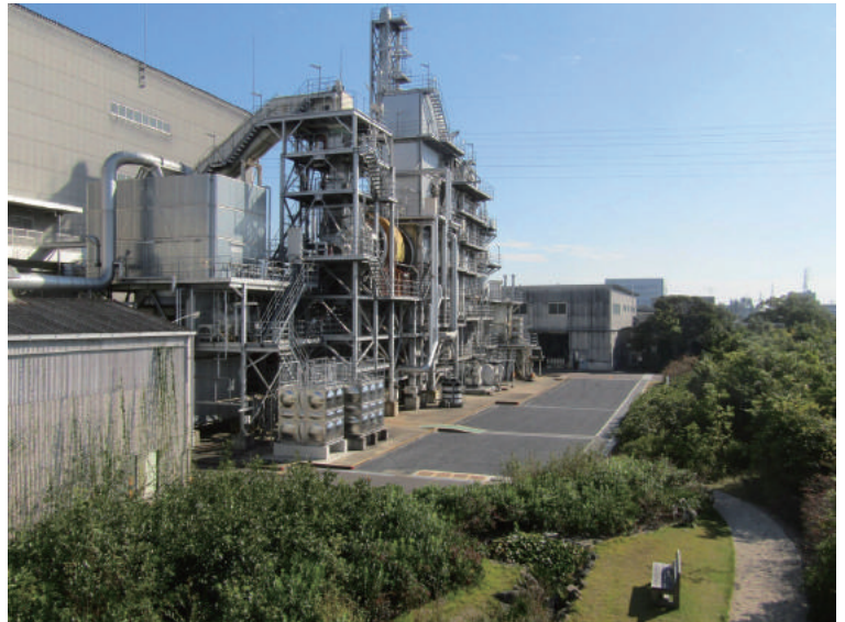
サステナブル廃棄物処理プラントの構築
