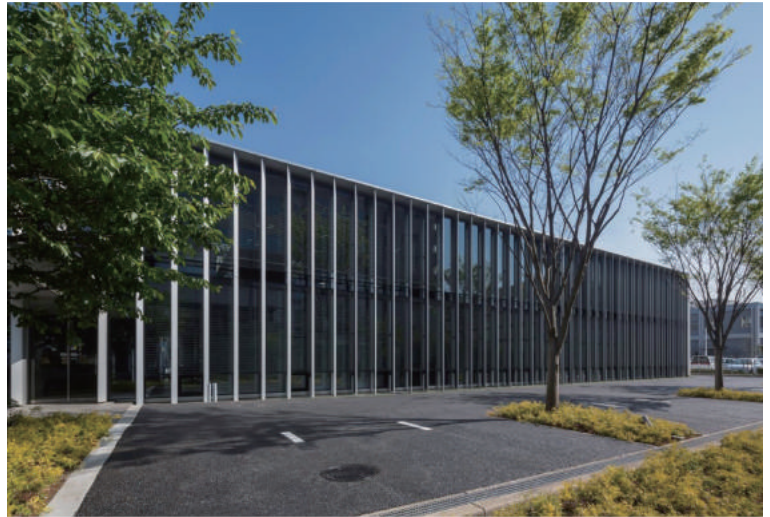
実用ビルで国内初のネットZEB化改修達成
