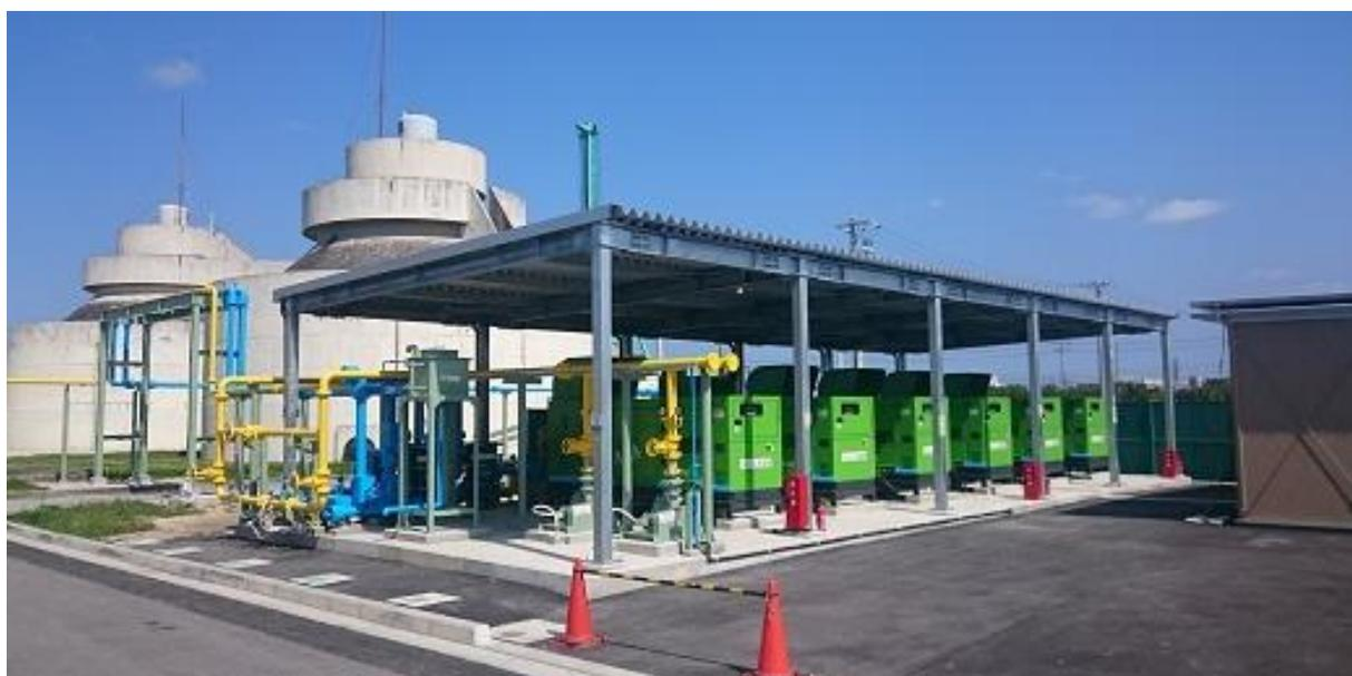
株式会社 NOSA バイオエナジー（以下、同社）は、沖縄の具志川浄化センターで発生する消化ガスを燃料としたバイオマス発電事業を行っている。
