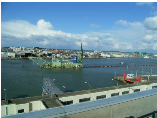
ポンプ浚渫船
