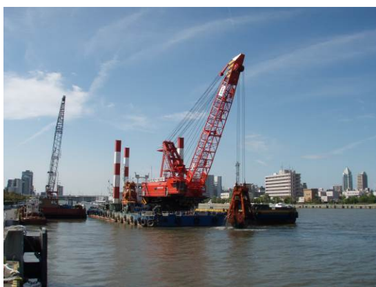
グラブ浚渫船と土運船
