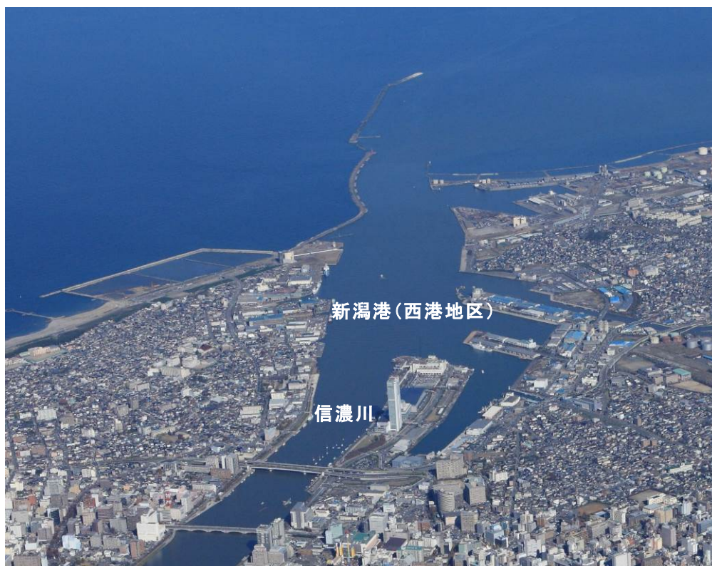
新潟港（西港地区）の現在の状況
