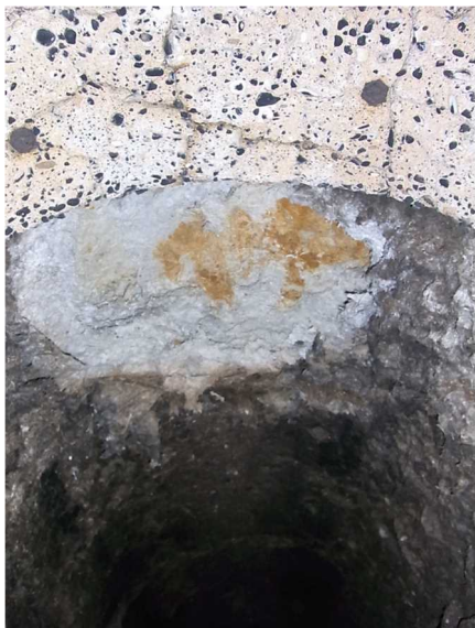
①煙突用石綿断熱材
