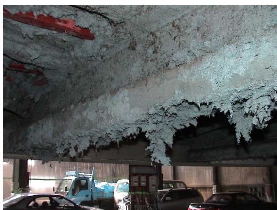
レベル1: 吹付け石綿(クロシドライト)
