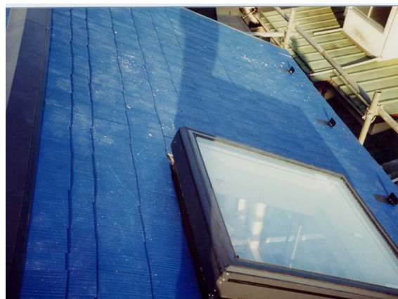
レベル3: 石綿含有住宅屋根用化粧用スレート
