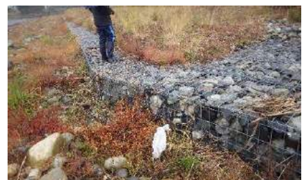
カゴマツト (拡大) (上流側から撮影)
