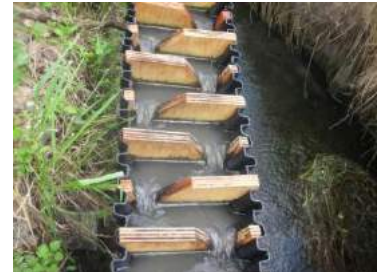
愛知農総試が開発した水田魚道 魚類が遡上しやすいスムーズな流れを形成 (写真提供：愛知県農業総合試験場)
