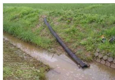
波付き丸形の設置状況
