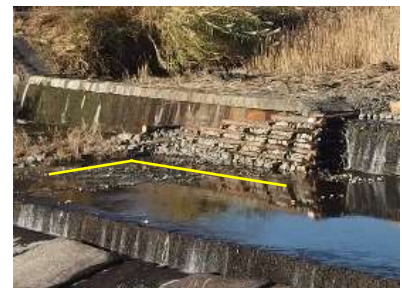
木杵土嚢魚道の設置場所（黄線）
