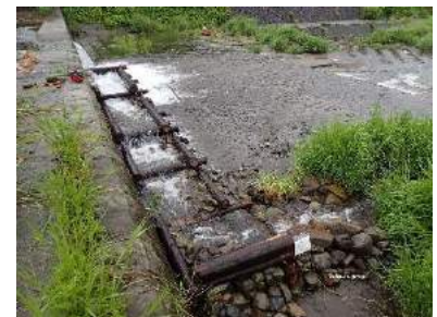
木杵土嚢魚道
