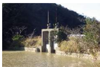
石淵地区の水門（陸側）
