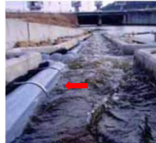
デニール式魚道内に設置されたシラスウナギ専用魚道（赤矢印のグレーの塩ビパイプ）
