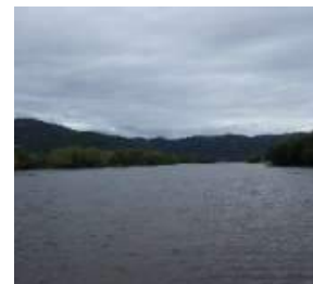
明星堰上流側
