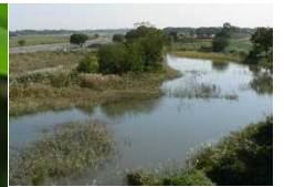
乾燥していた旧流路を掘削し 水面が再生 (H25.10.28)
