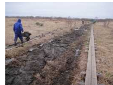
水抜き水路の埋め戻し
