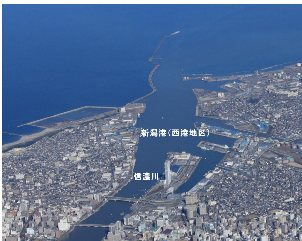
新潟港（西港地区）の現在の状況
