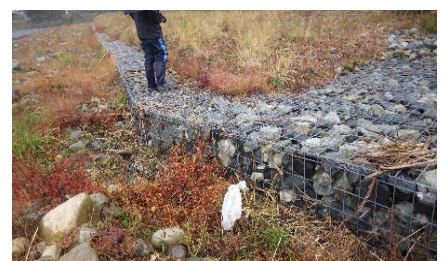
カゴマット (拡大) (上流側から撮影)
