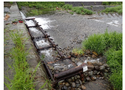
木柁土嚢魚道
