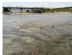
施工後に形成された瀬
