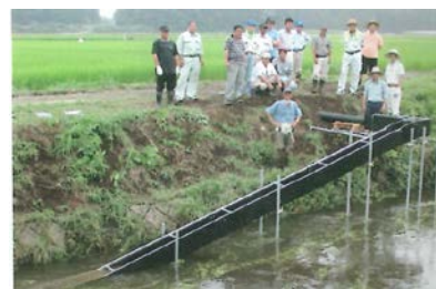
可動式魚道の設置状況
