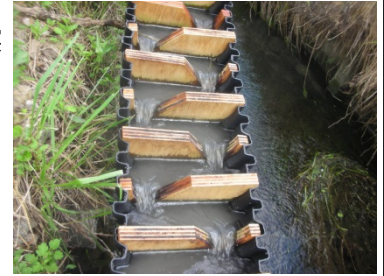
愛知農総試が開発した水田魚道 魚類が遡上しやすいスムーズな流れを形成
