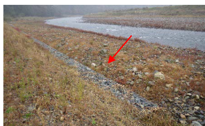
カゴマット (全体像) (下流側から撮影)
