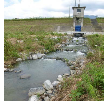
整備後（下境地区）
