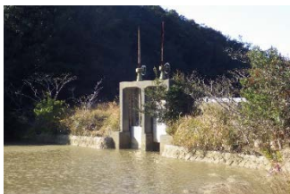
石淵地区の水門（陸側）
