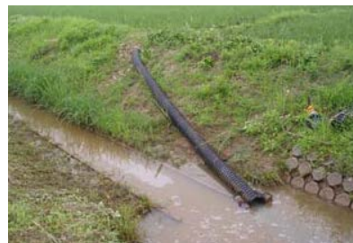
波付き丸形の設置状況
