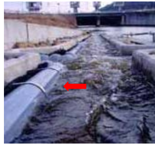
デニール式魚道内に設置されたシラスウナギ専用魚道 (赤矢印のグレーの塩ビパイプ)
