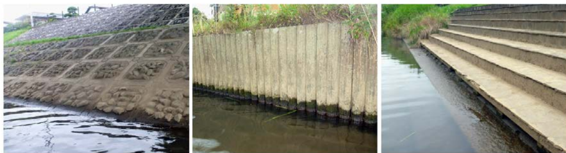
図 11 : コンクリート等で固められた水際の例 (Itakura et al. 2015b)
