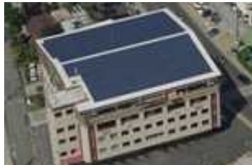
太陽光発電 (パシフィックコンサルタンツ) 太陽 光パネル：京セラ製
