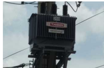
高効率アールファス変圧器 (裕幸計装) アールファス金 属：日立金属製
