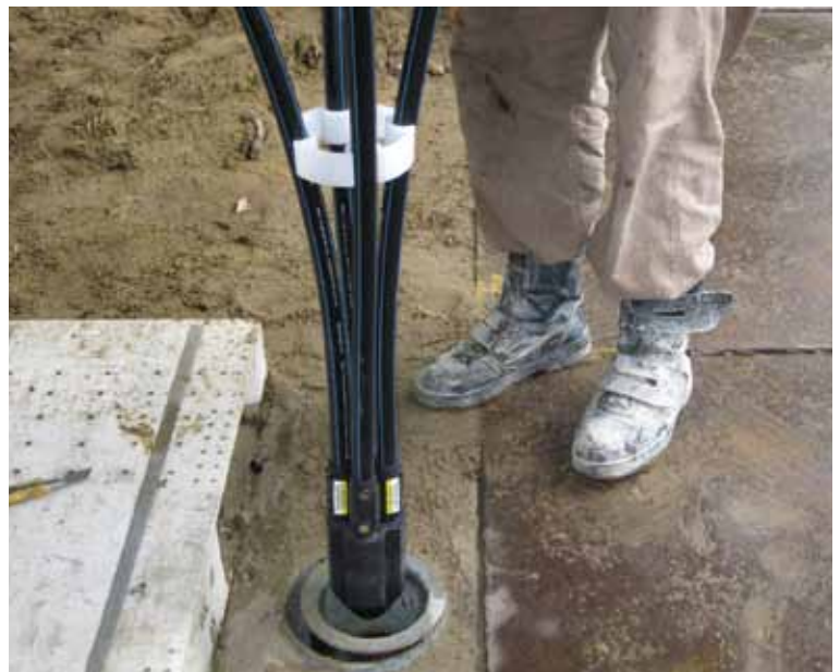
分岐管方式の地中熱交換器
