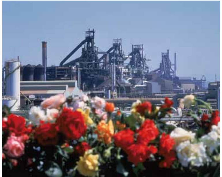
気体燃料吹込み焼結法によるクリーンな製鉄所の実現
