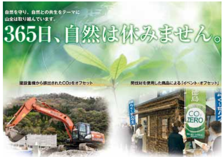
建設工事現場発!! カーボン・オフセットの取り組み
