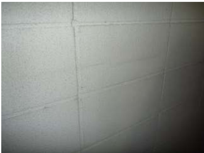
①石綿含有仕上塗材(薄塗材(樹脂リシン))
