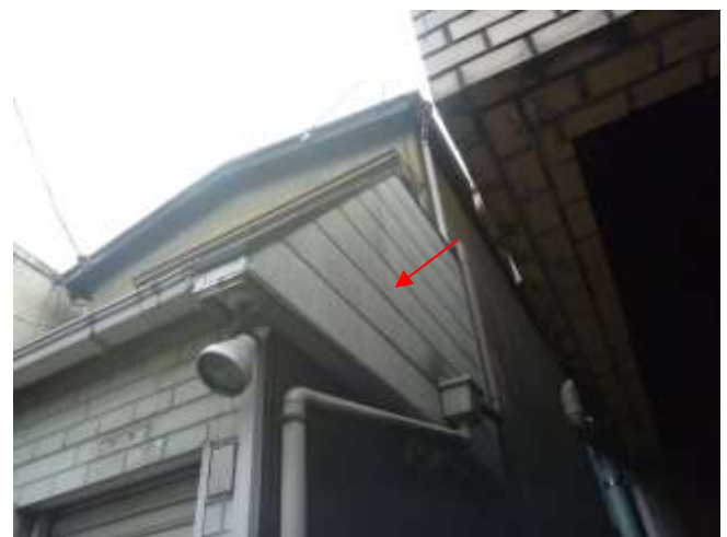
⑥石綿含有窯業系サイディング
