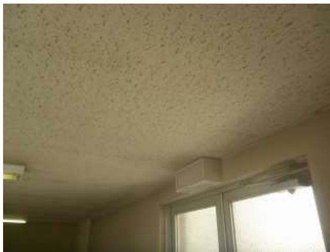
③石綿含有ロックウール吸音天井板
