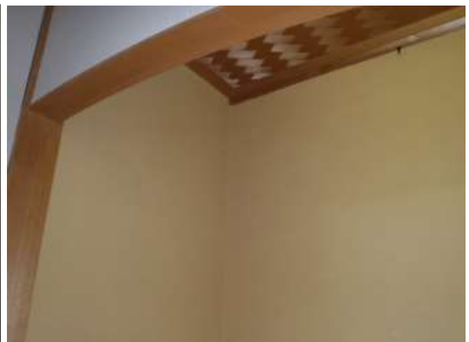
②石綿含有仕上塗材(内装薄塗材)
