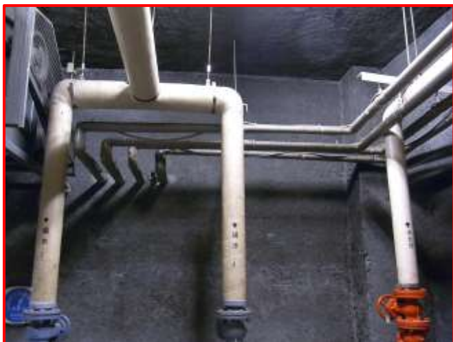
①吹付け石綿(クロシドライト)
