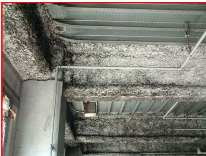
②石綿含有吹付けロックウール
