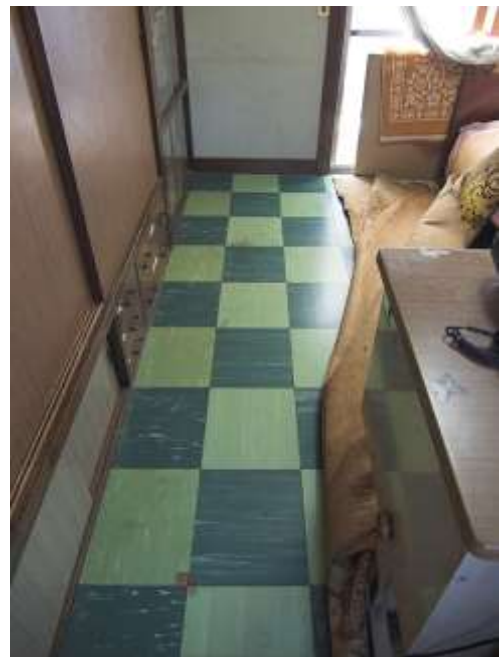
④石綿含有ビニル床タイル
