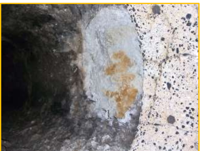
④煙突用石綿断熱材
