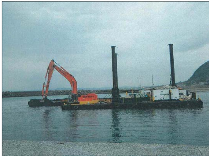
図-3.1 浚渫作業状況（例）
