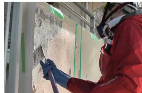
剥離剤併用手工具ケレン工法
