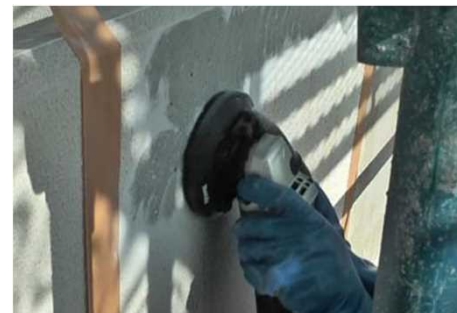
集じん装置併用手工具ケレン工法
