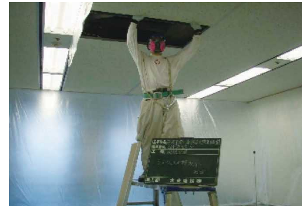
【石綿含有成形板等の除去例】
