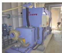
木質ペレット焚き温水ボイラー ニ光エンジニアリング社製 RE-35N 407kW
