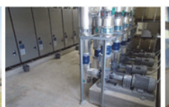
機械室内 ヒートポンプ・循環ポンプ
