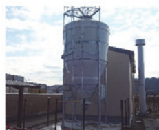
燃料タンク ニ光エンジニアリング社製 FTC-5 FRP製 9.8m³
