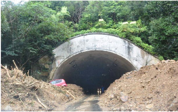
写真：土石流により不通となっていたトンネル （鹿児島県大和村 H22.10）
