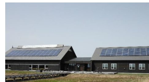
<太陽光発電設備>
