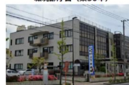
上下水道部合川庁舎（築36・52年）
