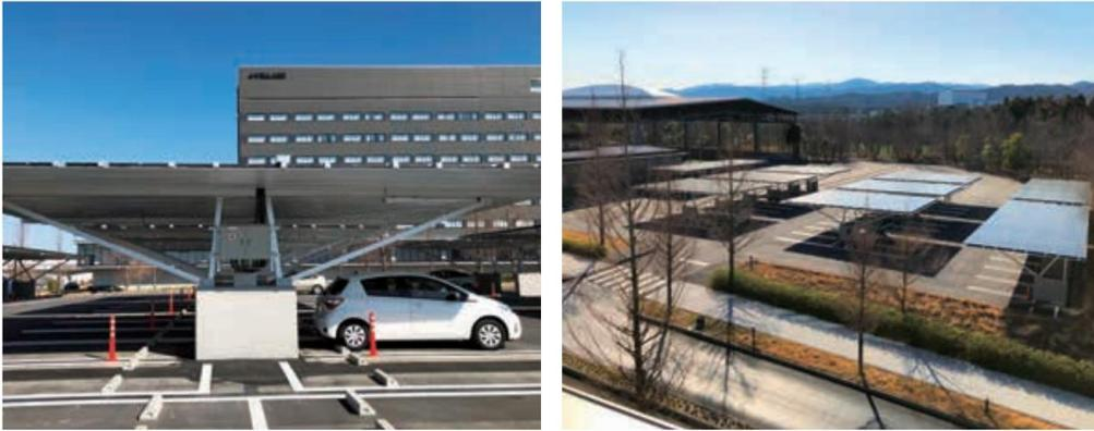
図 4-41 ソーラーカーポートの導入事例
