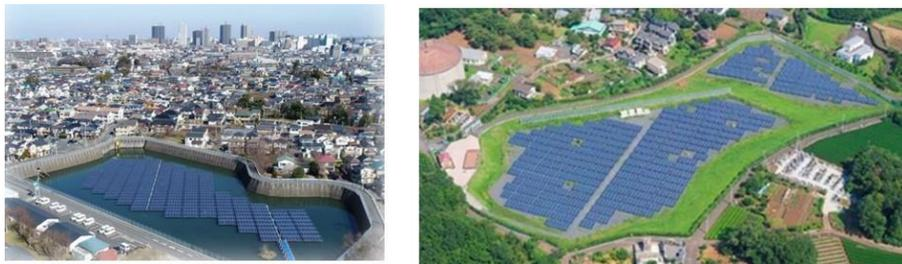
図 4-42 調整池・最終処分場への導入事例
