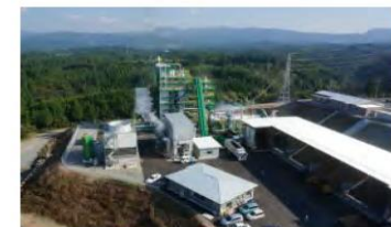
発電施設の外観
