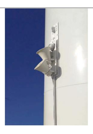
図-19 ギリシャでの導入例。4台のハイパワースピーカーのうちの2台 出典: DTBird Datasheet Eagles And Vultures Protection Read more at: <a href="http://www.dtbird.com/index.php/en/downloads">http://www.dtbird.com/index.php/en/downloads</a>
