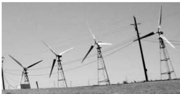
図 3-40 アルタモント風力資源地域で確認された彩色風車群(ブレード1枚を彩色)
