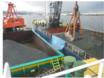
▲②ガット船から起重機船への積み替え
