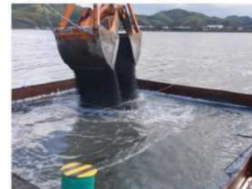
▲汚濁防止枠内へのHiビーズ投入 所定の厚さに覆砂するため、枠内を4分割し、投入回数を定め実施。(投入バケットのサイズ:4m3)
