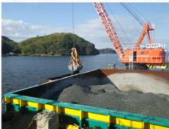
▲③起重機船によるHiビーズ覆砂
