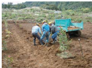
▲土壌ブロックの移植作業
