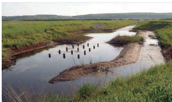
▲豊富3号排水路沈砂池
