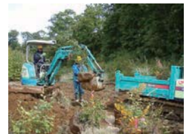
▲機械による掘取り
