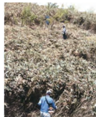
繁茂したササの除去作業
