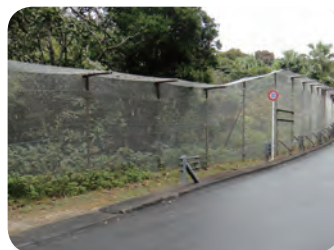
父島東平 ノネコノヤギ侵入防止柵
