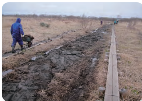
水抜き水路の埋め戻し
