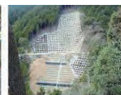
崩壊地の復旧工事
