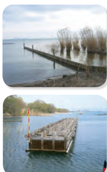
突堤（上）と消波堤（下）
