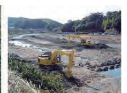
川にたまった土砂を取り除く工事
