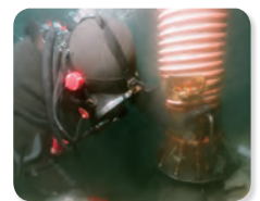
泥土除去状況（吸引）
