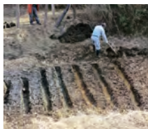
土砂堆積部分の浚渫
