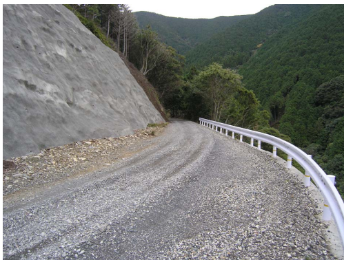
復旧された林道
