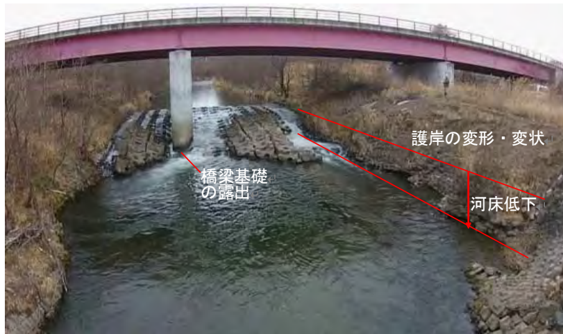
図 5-15. 雪裡川中流部における河床低下の状況
