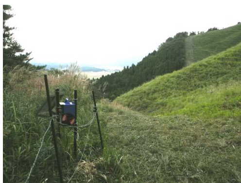
跡ヶ瀬牧野（急傾斜地に面的に設置）
