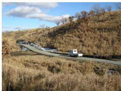
コンクリート舗装（湯浦牧野）
