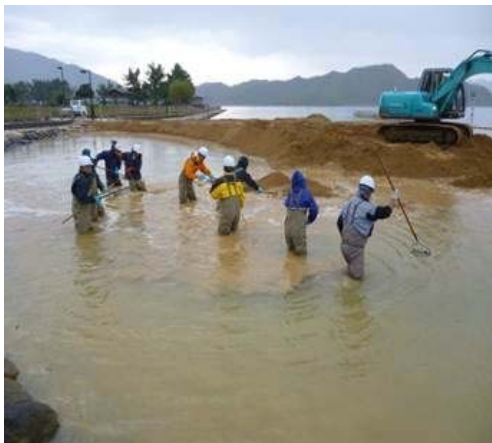
写真 3.7-1 浅場造成の様子
