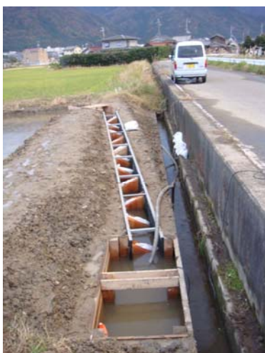
写真 3.5-1 水田への魚類の遡上を助ける水田魚道
