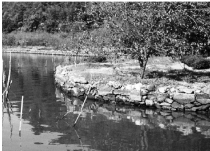
写真 3.1-1 目標設定の参考として収集する資料の例（昭和 50 年頃の石積み護岸）
