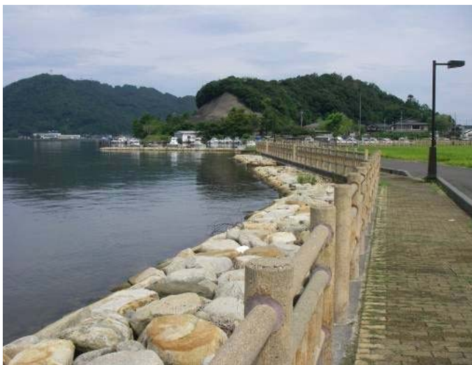
図 3.1-21 浅瀬護岸（捨石+砂投入）
