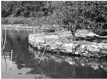
石積み護岸（昭和 50 年頃）
