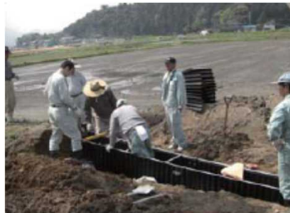
水田魚道の設置
