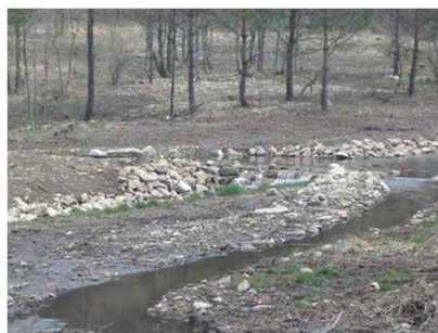
導水路の整備
