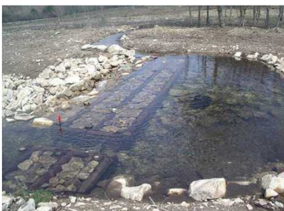
取水堰の設置
