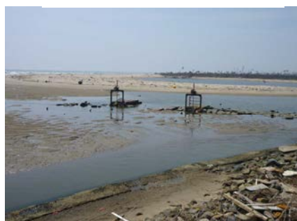
動流堤の被災状況(H23.8月)
