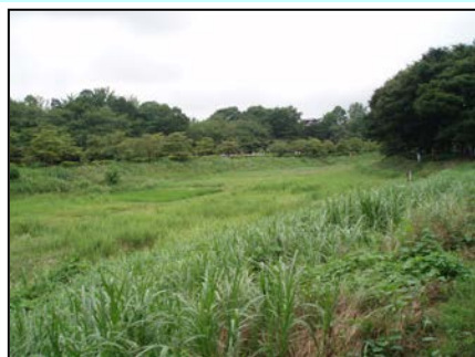
野川第一調節池（東側）
