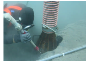
泥土除去状況
