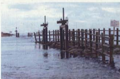
導流堤の老朽化による砂、海水の流入
