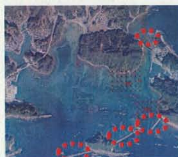
防波堤整備箇所(赤点線部分)
