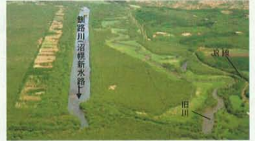
直線化した河道 (旧川復元による再蛇行化を計画)
