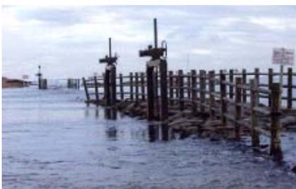
導流堤の老朽化による砂、海水の流入
