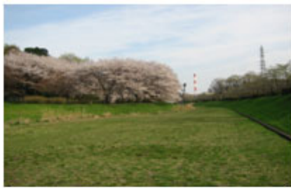
野川第一調節池
