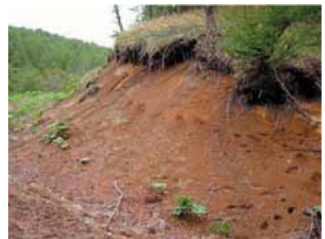
土砂流出が懸念される箇所
