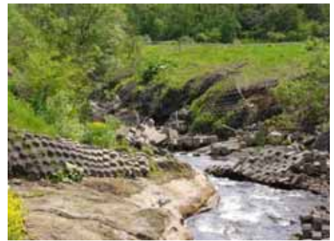
川底が削られた河川
