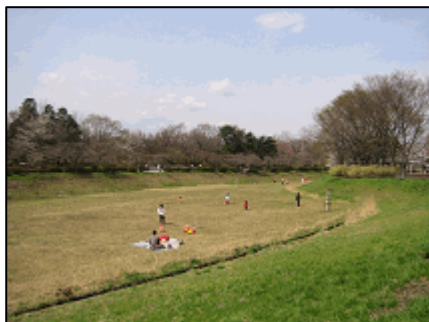
野川第一調節池（東側）
