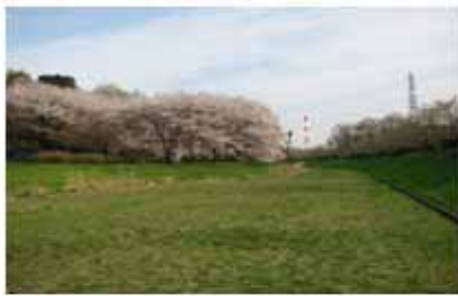
野川第一調節池
