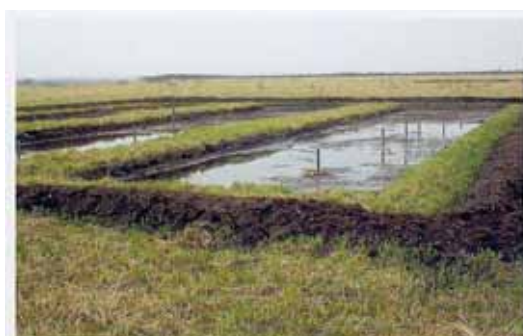
敷地跡地の地盤盛り下げ作業。面積は3箇所計で約0.3ha（平成15年5月）
