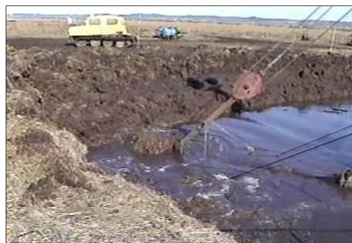
アームに付いた直径 1.5mカッターを左右に振って泥炭を切り出す様子。
