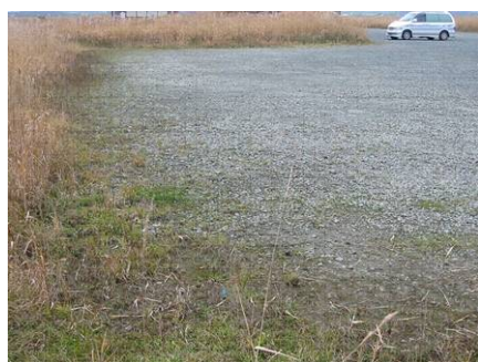
図 4-13 敷地駐車場の様子
