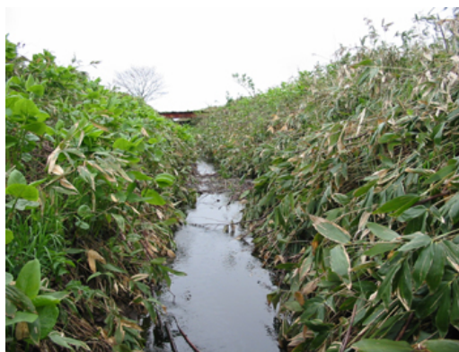
図 4-6 側溝(サロベツ川合流付近)
