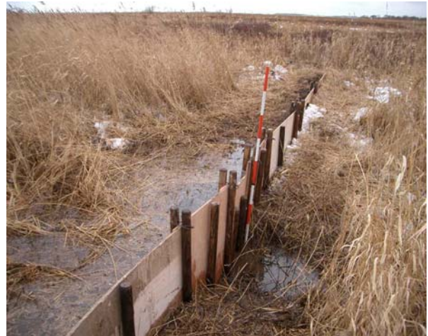
落合沼流出部 堰上げ直後の状況 (堰の延長は 10.5m、水路底から約 1.1m 堰上げ)
