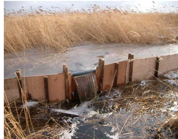
落合沼流出部 堰上げ2日後の状況 (融雪等の影響で相当量の越流が生じている)
