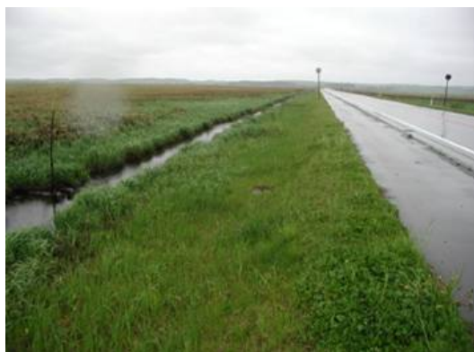
図 4-5 丸山道路と側溝
