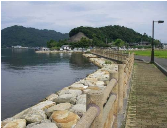
図 3.1-21 浅瀬護岸（捨石+砂投入）
