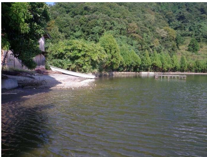
図 3.1-22 浅瀬護岸（砂のみ投入）
