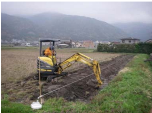
写真 3. 2-3 退避路の設置（施工中）
