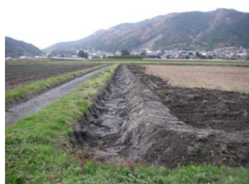
写真 3. 2-4 退避路の設置（施工後）
