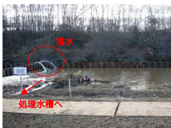
河道内沈殿池の利用
