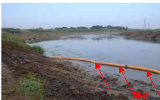
シルトフェンスによる濁水流出・拡散の防止
