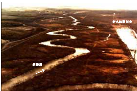
写真 3-1 新水路工事中（1976 年撮影）
