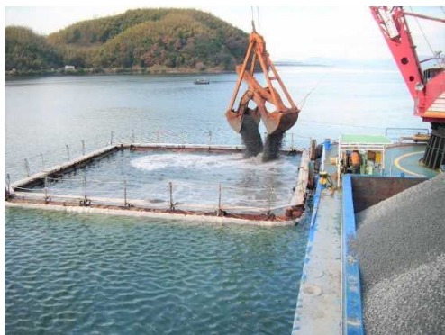
窪地埋め戻し作業
