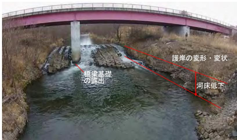
図 5-15. 雪裡川中流部における河床低下の状況
